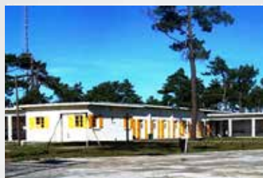
Centre Vent d'Est Montalivet (33)
