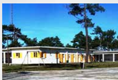
Centre Vent d'Est Montalivet (33)
