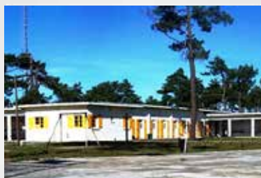
Centre Vent d'Est Montalivet (33)
